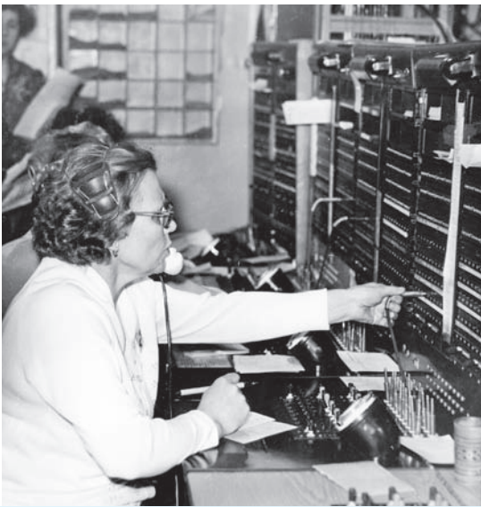
Рабочий момент на участке междугородной телефонной станции узла связи. За коммутатором Мария Лыжина.
